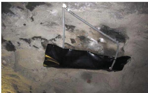
Detalhe de drenos para captar água de infiltração - alguns com manta asfáltica
