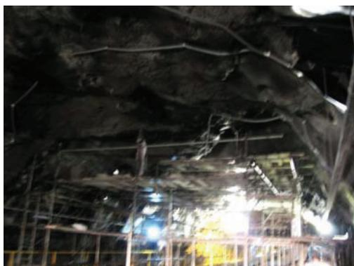
Drenos instalados nos túneis para sanar infiltrações
